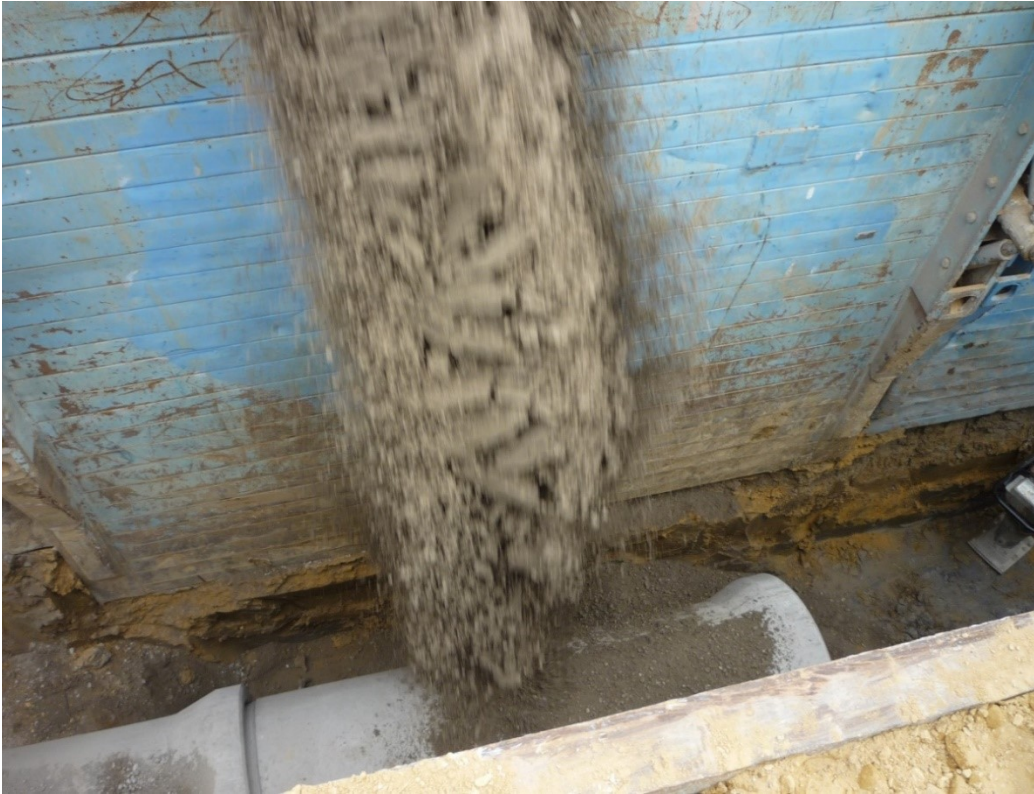
Remblayage du sol environnant sur les côtés
