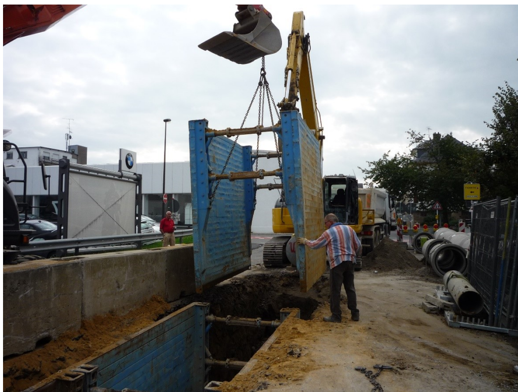
Mise en œuvre de l'étaiyage
