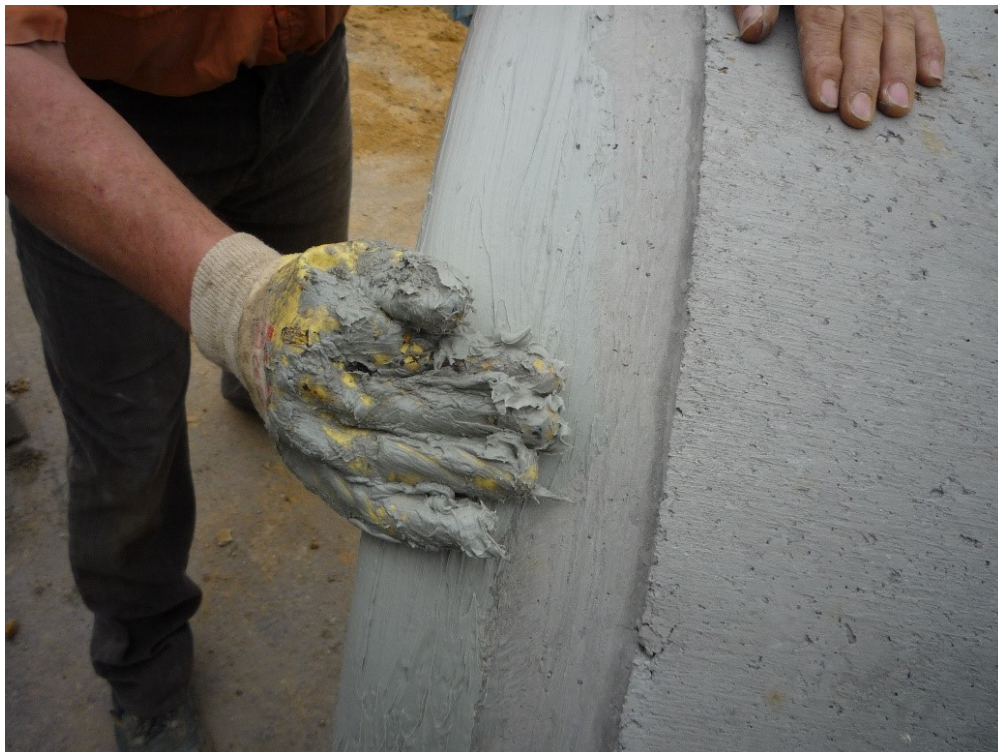
Application du lubrifiant sur l'embout mâle (raccord de tuyau avec joint intégré au manchon ; diamètre nominal 300 – 1200)
