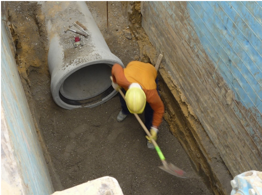
Réalisation de la fondation
