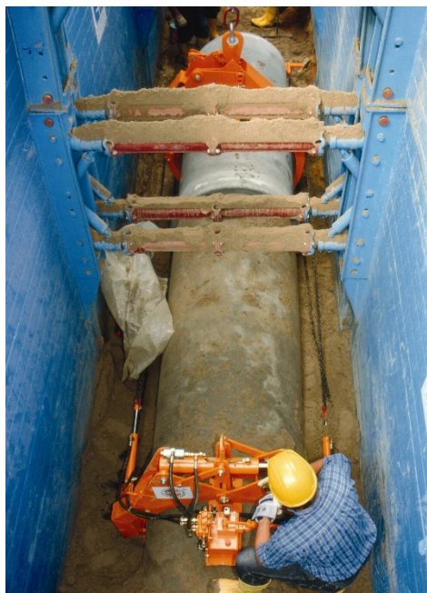
Assemblage des tuyaux avec équipement spécial
