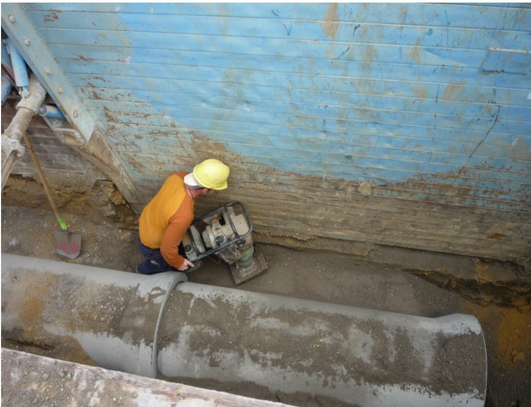
Compaction du sol environnant sur les côtés
