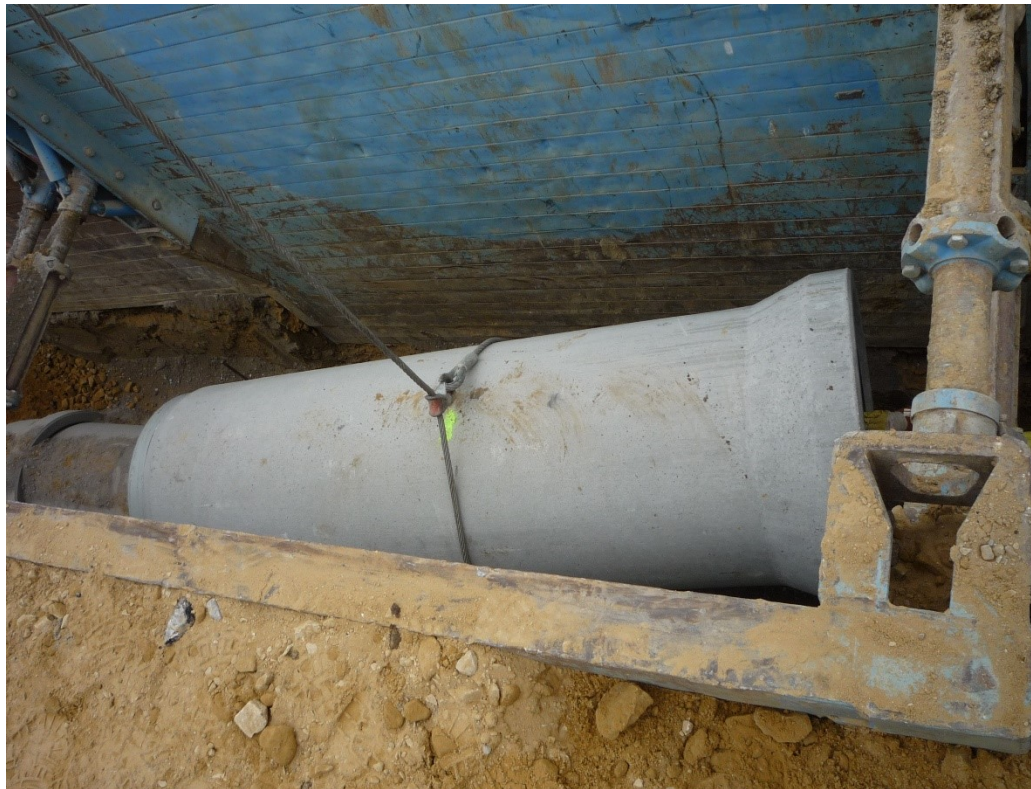
Dépose dans la tranchée
