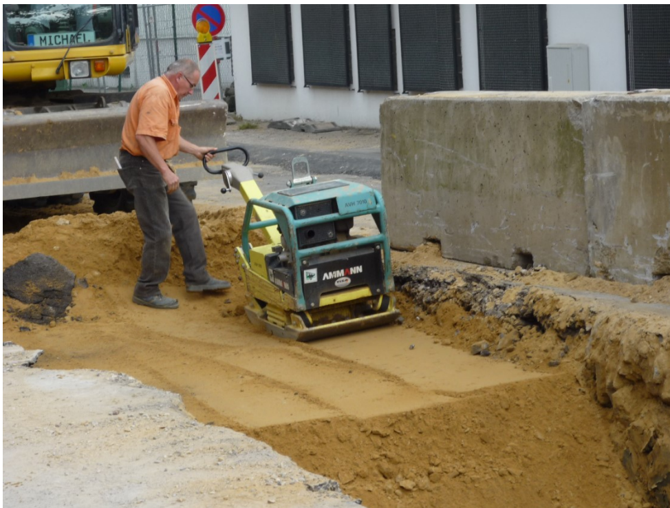
Réalisation du remblayage principal
