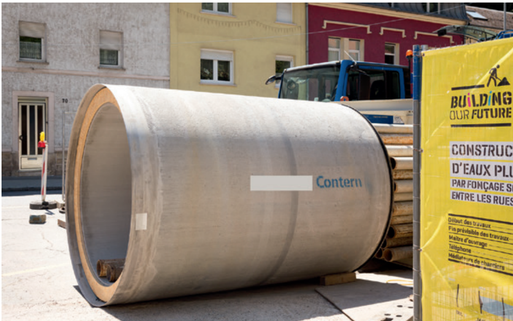
DN 1800/2200, Longueur utile / Baulänge 3,00 m
