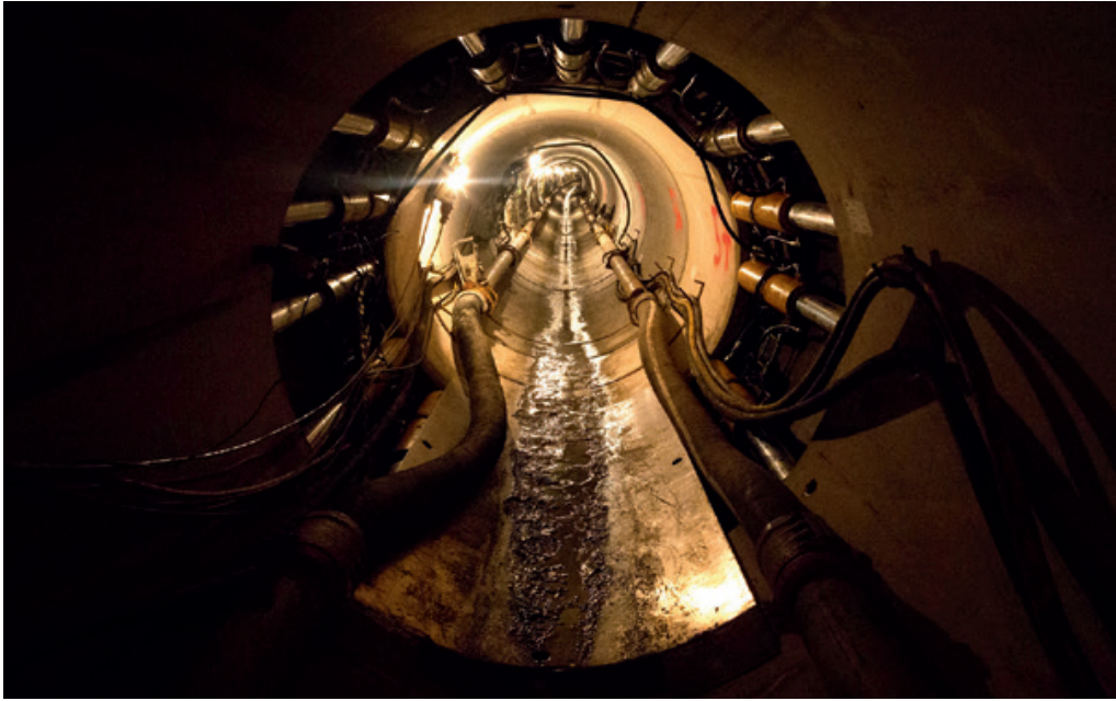
Station intermédiaire / Zwischenpreßstation
