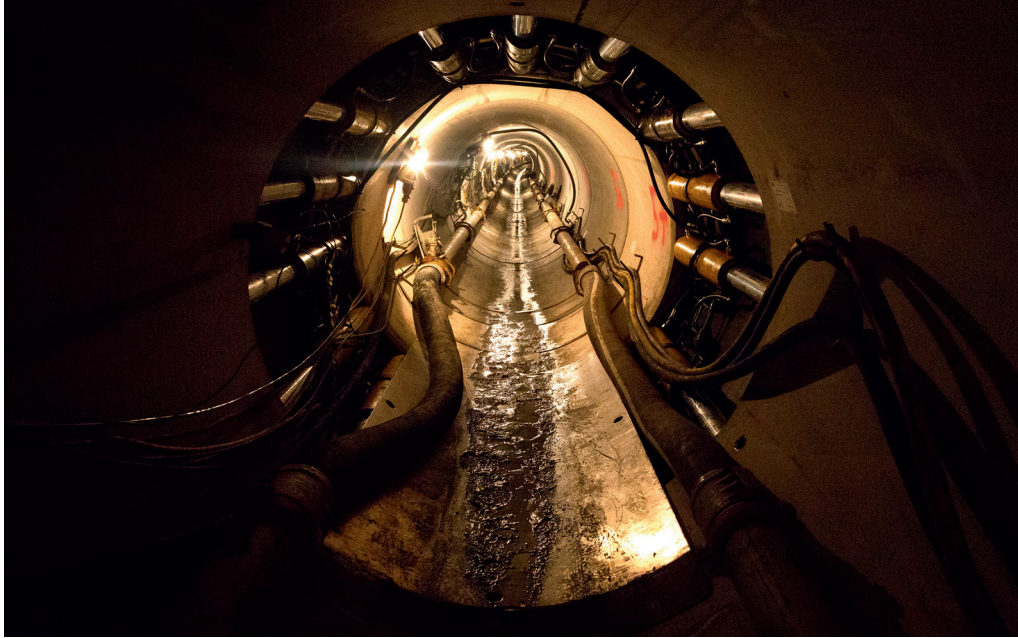
Station intermédiaire / Zwischenpreßstation
