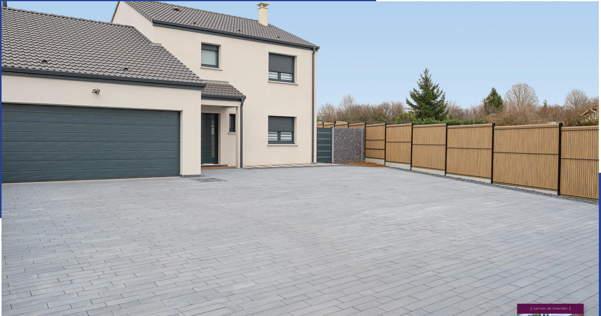
! **DE FAÇON SPÉCIFIQUE ET EXCEPTIONNELLE, LES PAVÉS BÉTON PEUVENT ÊTRE POSÉS SUR MORTIERS OU SUR BÉTONS. SE RÉFÉRER À LA NORME NFP 98335.**
