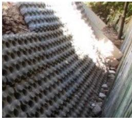
Une attention particulière devra être prêtée au lit de pose lors d'une pose en talus. Ici, le lit de pose devra être constitué de matériaux drainants et stables. La pose d'un géotextile permettra d'éviter une érosion du talus. Un emploi d'éléments d'ancrage au terrain est recommandé en cas de forte pente.
