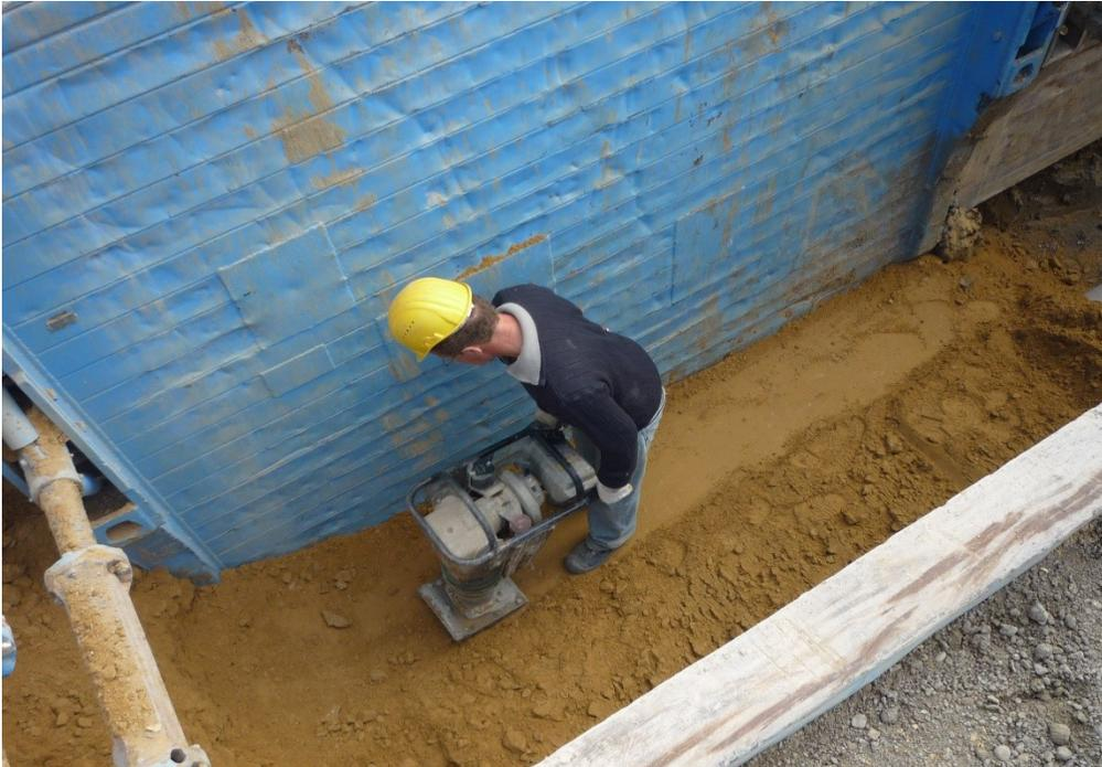
Verfüllen und Verdichten mit leichtem Verdichtungsgerät (<1,0m Überdeckung)
