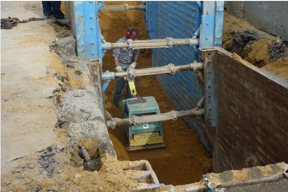
Verfüllen und Verdichten mit mittleren Verdichtungsgerät (>1,0m Überdeckung)
