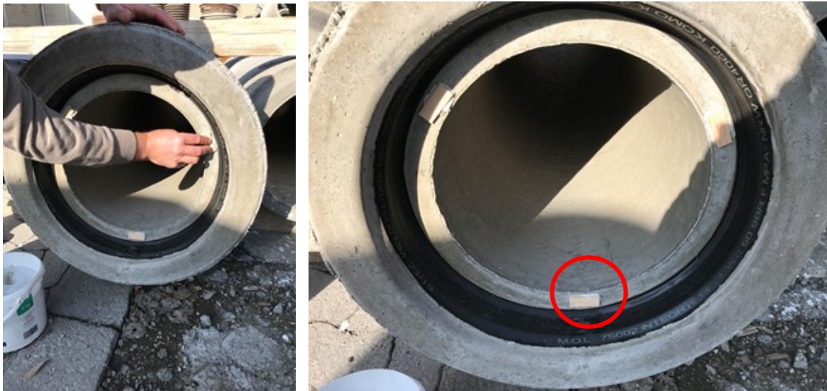
Fixation de plaques en bois de 5mm d'épaisseur
