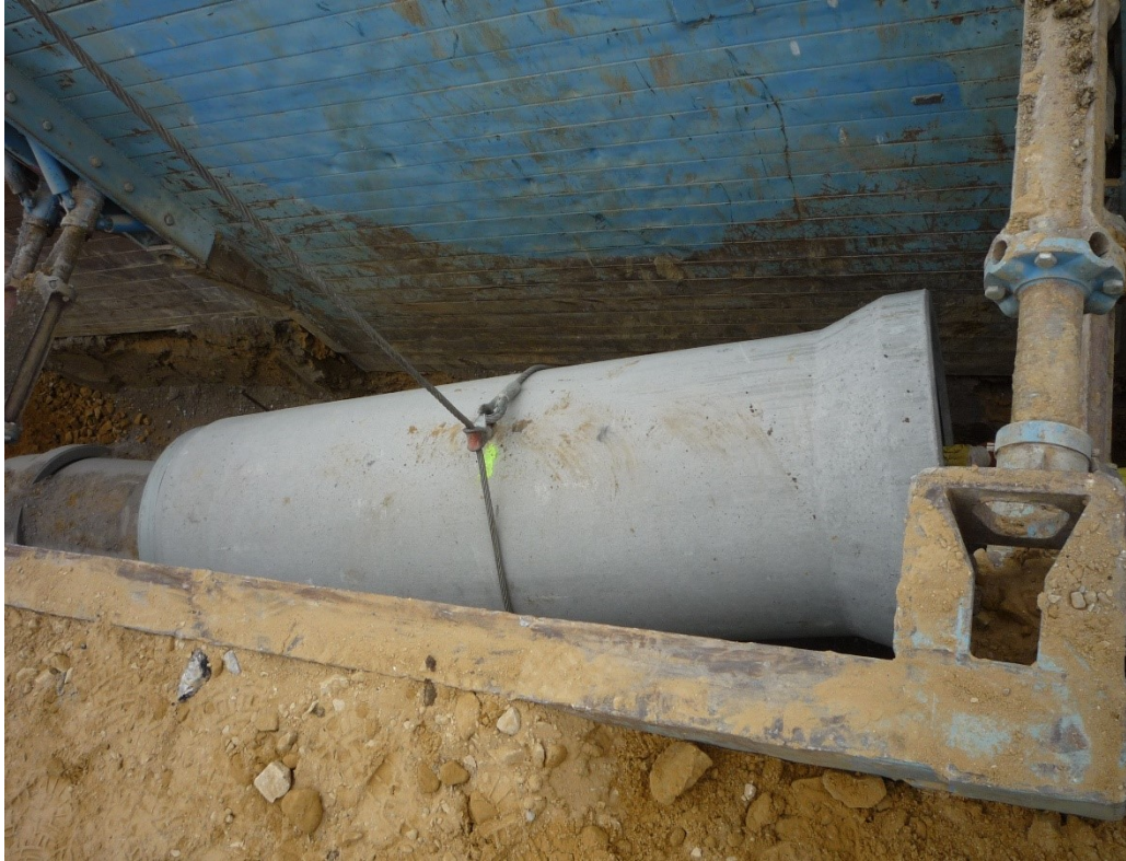
Dépose dans la tranchée
