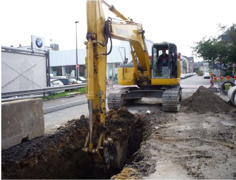
Excavation de la tranchée destinée à recevoir le tuyau
