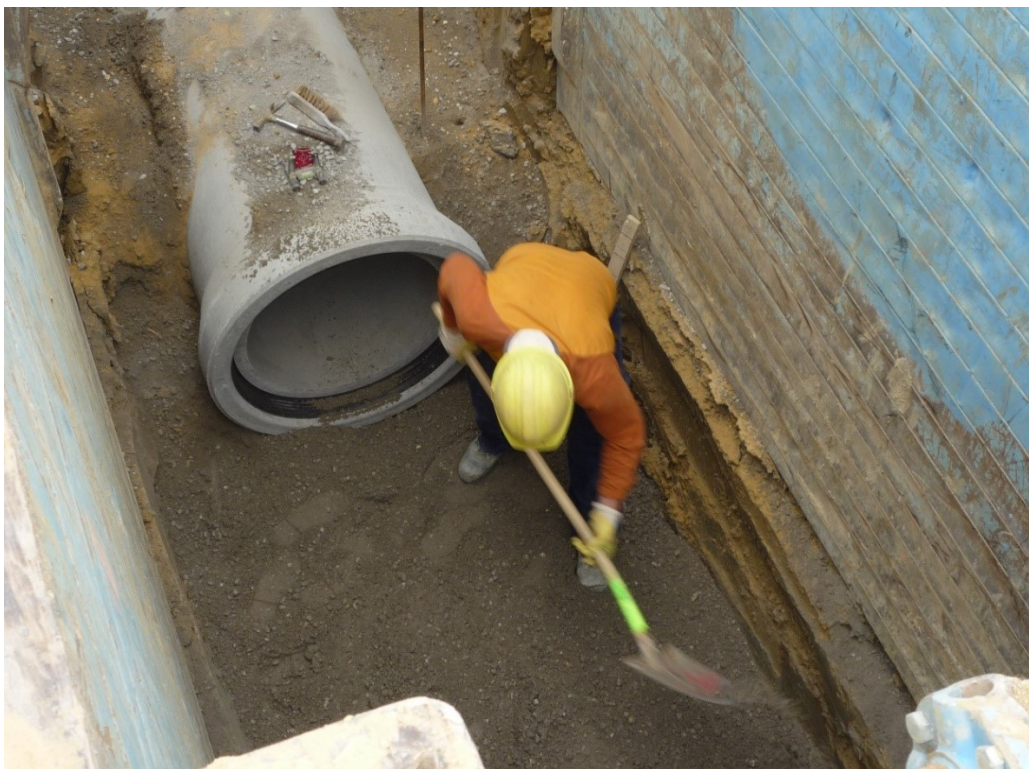
Réalisation de la fondation
