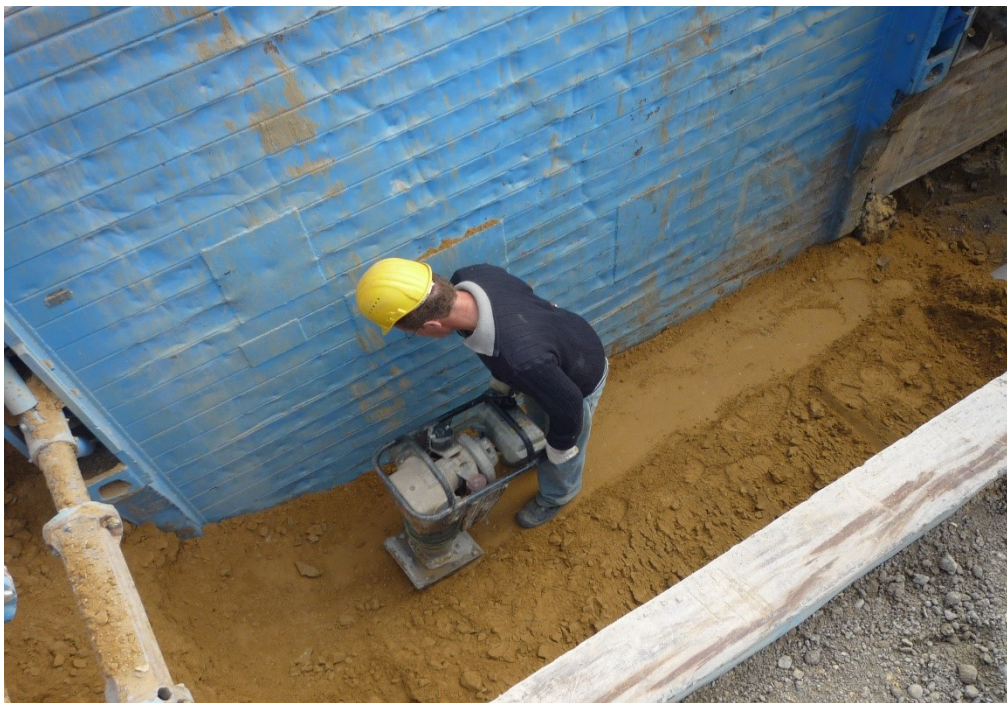
Remblayage et compactage avec appareil de compactage léger (< 1,0 m de recouvrement)
