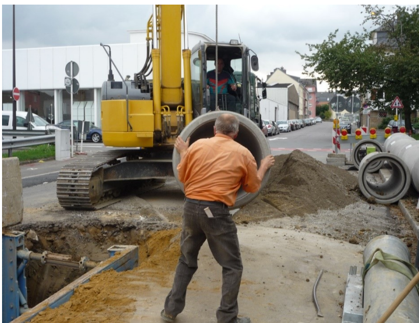
Inspection des tuyaux avant la pose
