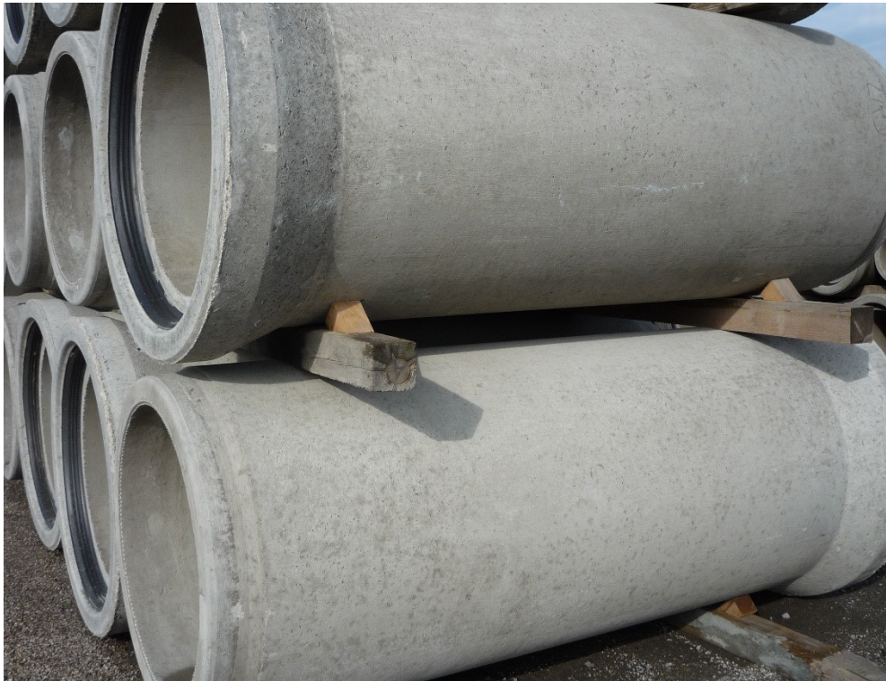
Tuyaux en béton armé entreposés correctement sur chantier
