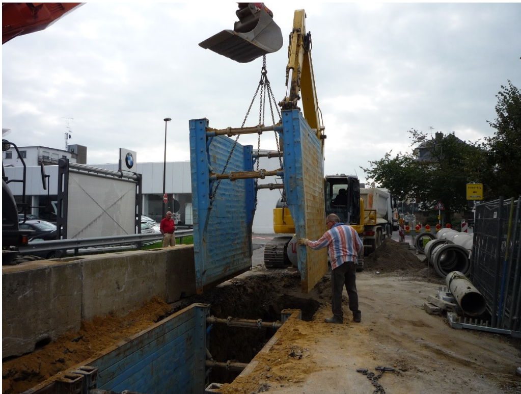
Mise en œuvre de l'étaiyage
