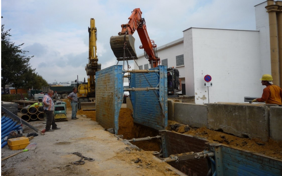
Retrait de l'échafaudage
