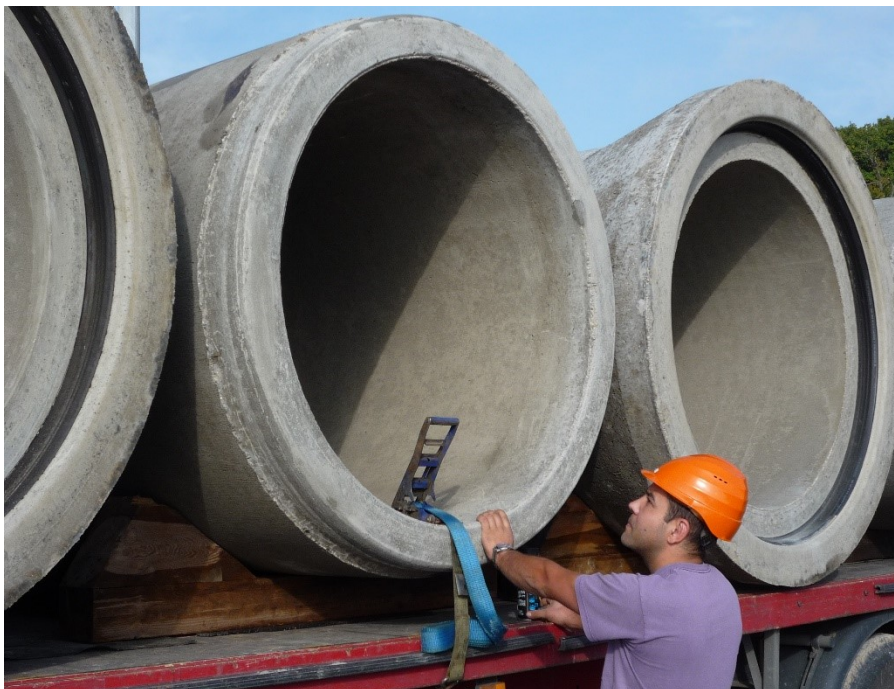
Réception des tuyaux (qui reposent sur le camion)
