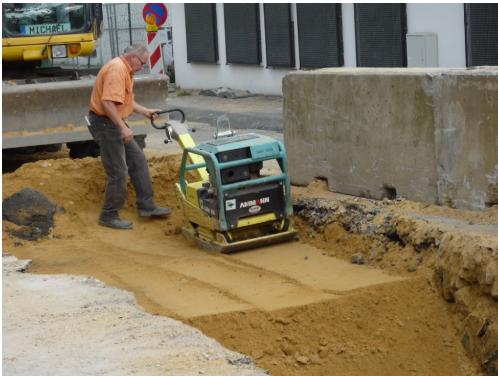
Réalisation du remblayage principal
