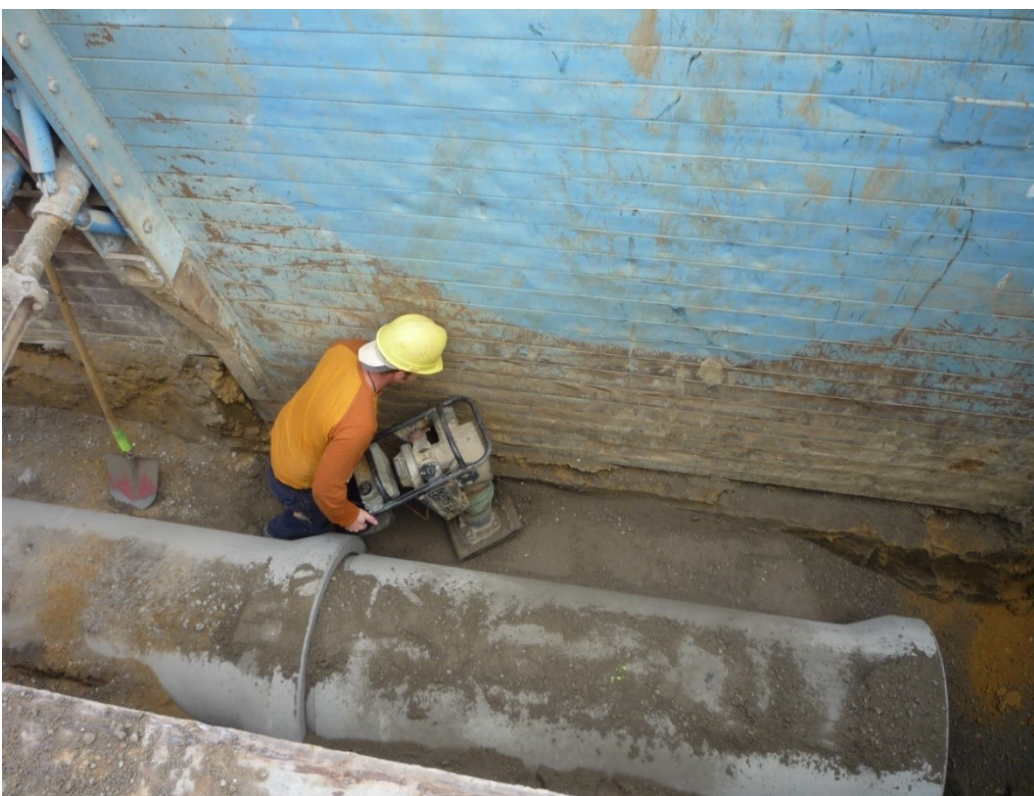
Compactage du sol environnant sur les côtés
