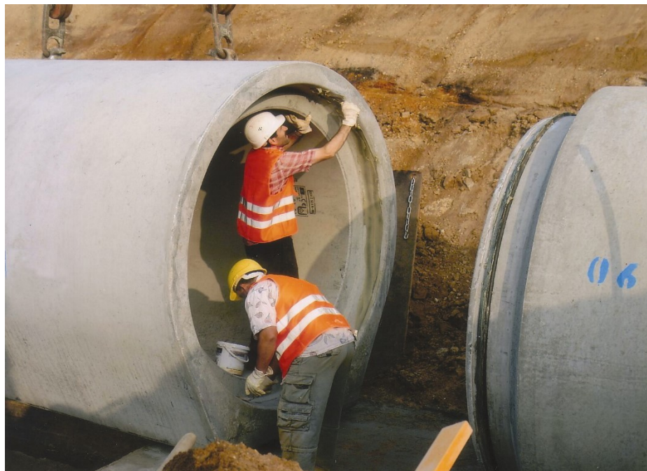
Application du lubrifiant dans le manchon (raccord de tuyau avec bague coulissante sur l'embout mâle, diamètre nominal 1400 – 3000)
