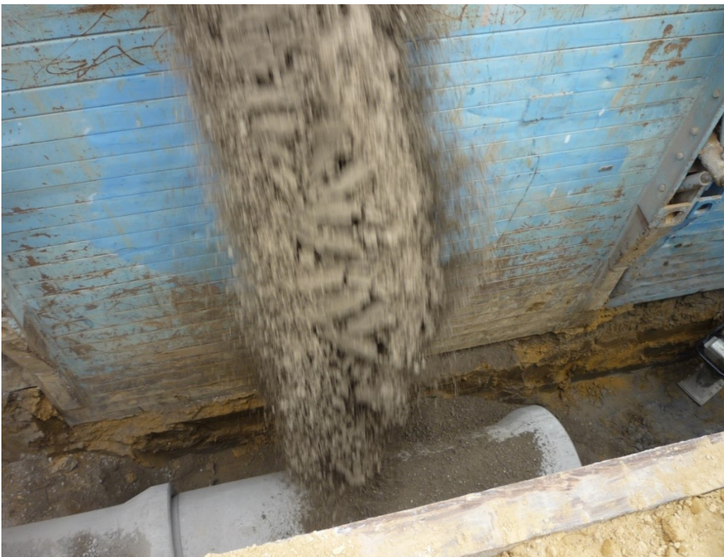
Remblayage du sol environnant sur les côtés
