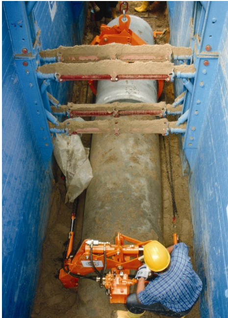
Assemblage des tuyaux avec équipement spécial
