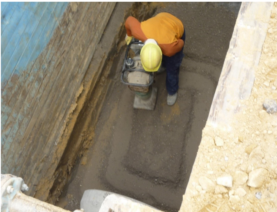
Réalisation de la fondation
