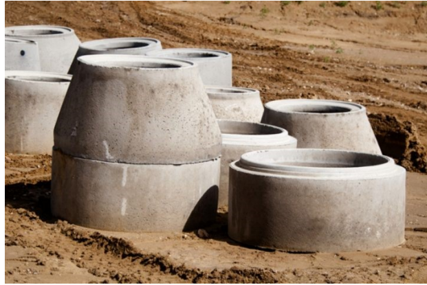
Exemples de déchargement correct et de bon stockage sur le chantier
