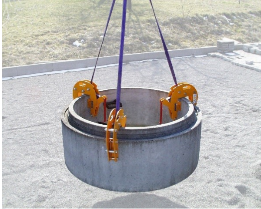
Exemples de déchargement correct et de bon stockage sur le chantier
