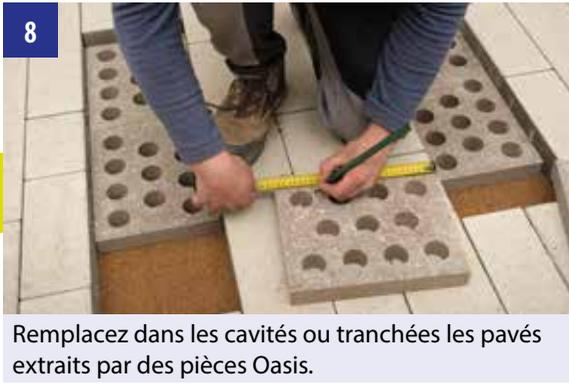
Remplacez dans les cavités ou tranchées les pavés extraits par des pièces Oasis.
