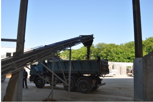
Verladung im Werk von Contern
