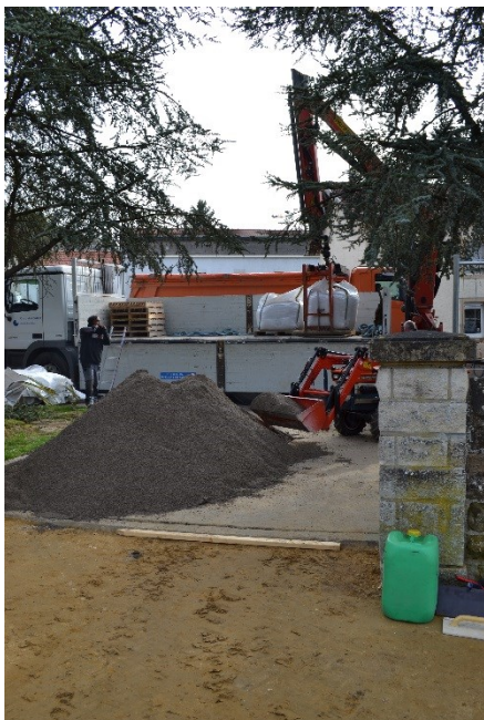
EcoParcLane auf der Baustelle abgeladen
